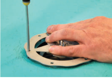
GÖR HÅL ÖVER GÄNGTAPPARNA 11. Gör hål/snitt över gängtapparna.
