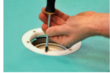
MONTERA KLÄMRINGEN 13. Montera klämringen och skruva dit de medföljande skruvarna växelvis diagonalt
